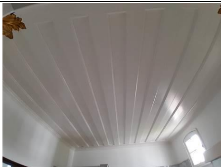
Photo n° PhPb049 Localisation : 1er étage - Sainitaires Pièce 46 UD : Plafond Type de dégradation : NC - Substrat : Plafond - Bois - Revêtement : Peinture - Mesure : 3,1
