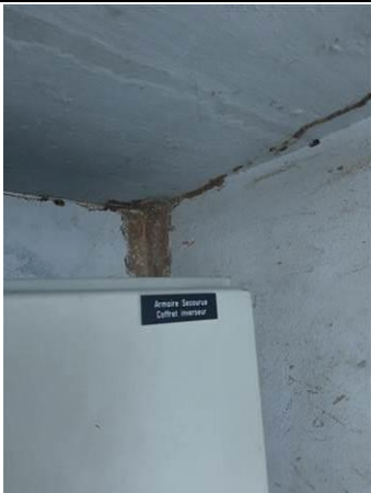
Photo n° PhTer005 Localisation : Rez de chaussée - TGBT Ouvrage : Mur - Béton Parasite : Présence d'indices d'infestation de termites, Termites souterrains Indices : présence de cordonnets
