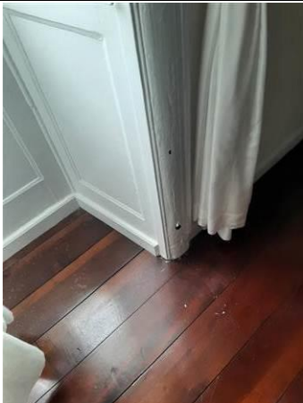
Photo n° PhTer012 Localisation : 1er étage - Pièce 46 Ouvrage : Fenêtre - Bois Parasite : Présence d'indices d'infestation de termites, Termites souterrains sur cadre fenêtre
