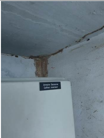
Photo n° PhTer004 Localisation : Rez de chaussée - TGBT Ouvrage : Plafond - Faux plafond Parasite : Présence d'indices d'infestation de termites, Termites souterrains Indices : présence de cordonnets
