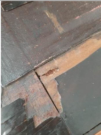
Photo n° PhTer011 Localisation : 1er étage - Pièce 45 Ouvrage : Table bois Parasite : Présence d'indices d'infestation de termites, Termites de bois sec
