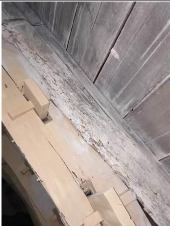
Photo n° PhTer014 Localisation : Combles Ouvrage : Charpente bois et structure bois Parasite : Présence d'indices d'infestation de termites, Termites souterrains
