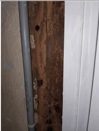
Photo n° PhTer015 Localisation : Combles Ouvrage : Porte - Bois Parasite : Présence d'indices d'infestation de termites, Termites souterrains sur bâti porte
