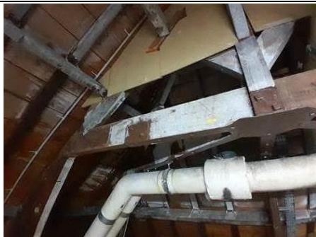
Photo n° PhPb060 Localisation : Combles UD : Platine fixation charpente Type de dégradation : NC - Substrat : Métal - Revêtement : Peinture - Mesure : 8,6
