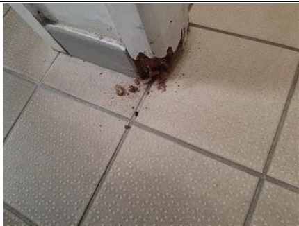
Photo n° PhTer002 Localisation : Rez de jardin - Sanitaires 4 Ouvrage : Porte - Bois Parasite : Champignon de pourriture molle sur bâti porte
