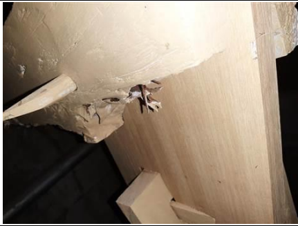
Photo n° PhTer014 Localisation : Combles Ouvrage : Charpente bois et structure bois Parasite : Présence d'indices d'infestation de termites, Termites souterrains
