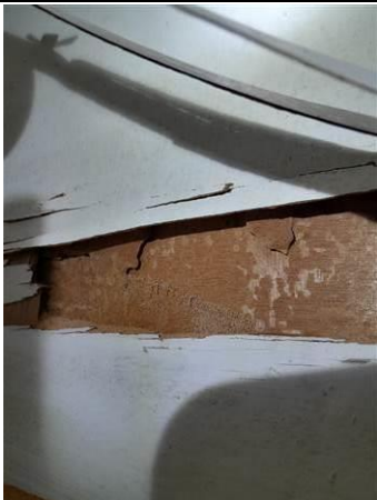
Photo n° PhTer009 Localisation : Rez de chaussée - Pièce 40 Ouvrage : Mur - Béton, bois Parasite : Présence d'indices d'infestation de termites, Termites de bois sec sur cloison bois
