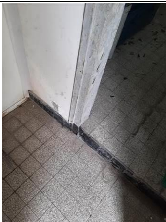
Photo n° PhTer003 Localisation : Rez de jardin - Cave à vin Ouvrage : Porte - Bois Parasite : Champignon de pourriture molle sur bâti porte
