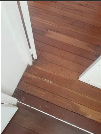
Photo n° PhTer010 Localisation : 1er étage - Pièce 45 Ouvrage : Sol - Bois Parasite : Présence d'indices d'infestation de termites, Termites souterrains sur parquet bois
