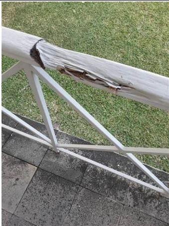
Photo n° PhTer020 Localisation : Extérieur à côté bureau du Préfet Ouvrage : Garde-corps bois Parasite : Champignon de pourriture molle
