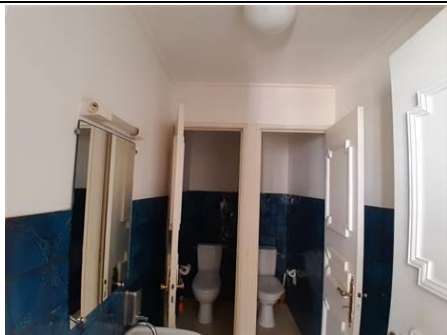
Photo n° PhPb052 Localisation : 1er étage - Sanitaires Dégagement 4 UD : Mur Type de dégradation : NC - Substrat : Mur - Béton, faïence - Revêtement : Peinture - Mesure : 1,1
