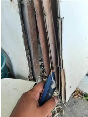
Photo n° PhTer021 Localisation : Rez de chaussée - Façade arrière Ouvrage : Coffrage contreplaqué Parasite : Présence d'indices d'infestation de termites, Termites de bois sec
