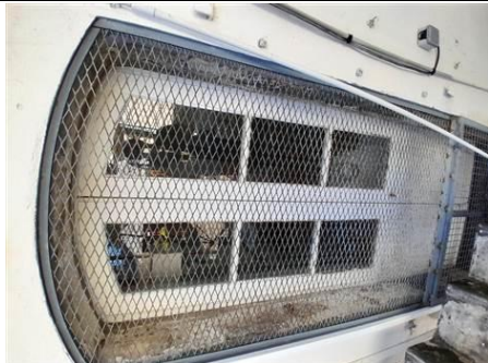
Photo n° PhPb016 Localisation : Rez de jardin - Pièce 14 UD : Grille anti-intrusion Type de dégradation : NC - Substrat : Métal - Revêtement : Peinture - Mesure : 3,9
