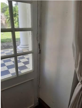
Photo n° PhTer007 Localisation : Rez de chaussée - Pièce 39 Ouvrage : Porte - Bois Parasite : Présence d'indices d'infestation de termites, Termites souterrains sur bâti porte
