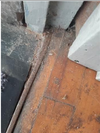
Photo n° PhTer008 Localisation : Rez de chaussée - Dégagement 3 Ouvrage : Porte - Bois Parasite : Présence d'indices d'infestation de termites, Termites de bois sec sur porte
