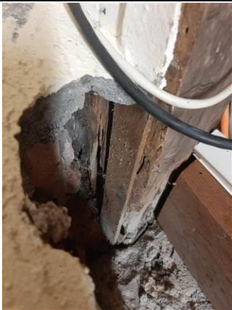
Photo n° PhTer006 Localisation : Rez de chaussée - Pièce 35 Ouvrage : Poteau bois Parasite : Présence d'indices d'infestation de termites, Termites souterrains
