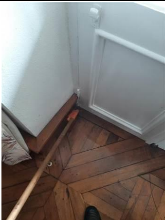
Photo n° PhTer013 Localisation : 1er étage - Salon de réception Ouvrage : Porte - Bois Parasite : Présence d'indices d'infestation de termites, Termites souterrains sur bâti porte
